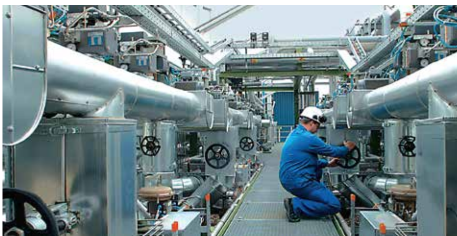
Steam-Reformer werden bei Linde verwendet, um leichte Kohlenwasserstoffe wie Erdgas mit Dampf in einem Spaltofen umzuwandeln. Dadurch entsteht ein wasserstoffhaltiges Gasgemisch, das für chemische Synthesen oder zur Gewinnung von reinem Wasserstoff verwendet wird. Foto: The Linde Group
