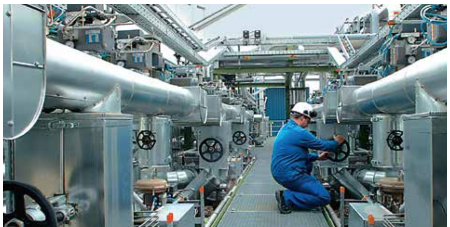
Steam-Reformer werden bei Linde verwendet, um leichte Kohlenwasserstoffe wie Erdgas mit Dampf in einem Spaltofen umzuwandeln. Dadurch entsteht ein wasserstoffhaltiges Gasgemisch, das für chemische Synthesen oder zur Gewinnung von reinem Wasserstoff verwendet wird. Foto: The Linde Group
